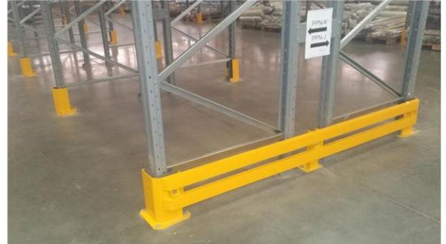
Protetor fabricado em perfil tubular com espessura de 3,75 mm.
